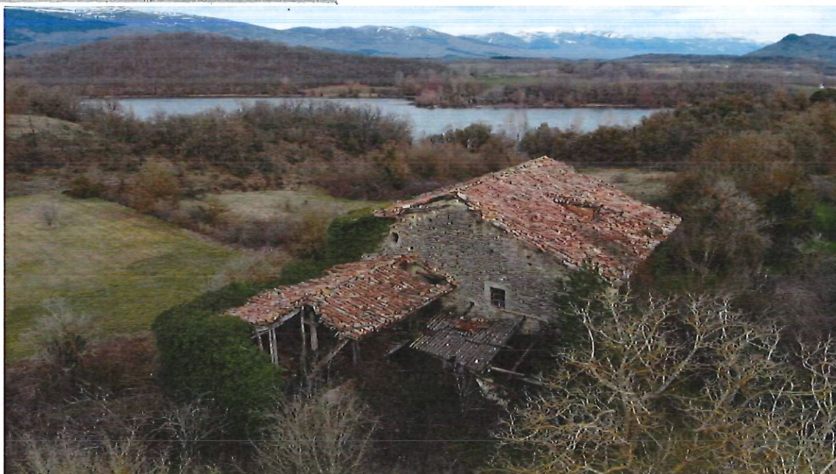
Fig.02: Estado del antiguo caserío de Garaio con fecha 14 de febrero de 2023 (Fuente: Atalaya Territorio, S.L.).
